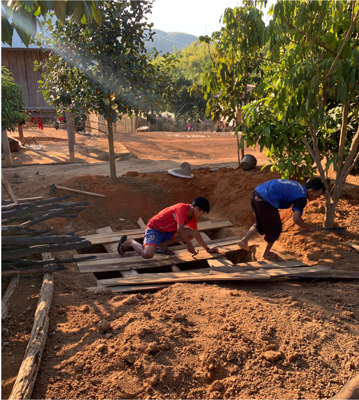
Construction des latrines
